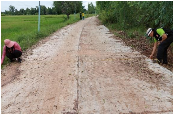
โครงการ ถนนบ้านดอนนอก หมู่ที่ 2 ตำบลหนองพลวง เข้ม บ้านถนนโพธิ์ หมู่ที่ 5 ตำบลประทาย อำเภอประทาย จังหวัด นครราชสีมา (ก่อสร้างถนนคอนกรีตเสริมเหล็ก กว้าง 4 เมตร ยาว 220 เมตร หนา 0.15 เมตร ตามแบบและรายละเอียดที่ อบจ.นม.กำหนด)
