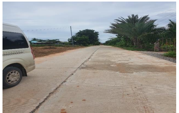
โครงการถนนบ้านทับม้า หมู่ที่ 10 ตำบลสีคิ้ว - บ้านมอดินแดง หมู่ที่ 6 ตำบลหนองหญ้าขาว อำเภอสีคิ้ว จังหวัดนครราชสีมา (ก่อสร้างถนนคอนกรีตเสริมเหล็ก กว้าง 5.00 เมตร ยาว 168 เมตร หนา 0.15 เมตร ไหล่ทางหินคลุกกว้างเฉลี่ยข้างละ 0.50 เมตร หรือพื้นที่ คสล.ไม่น้อยกว่า 840 ตารางเมตร)
