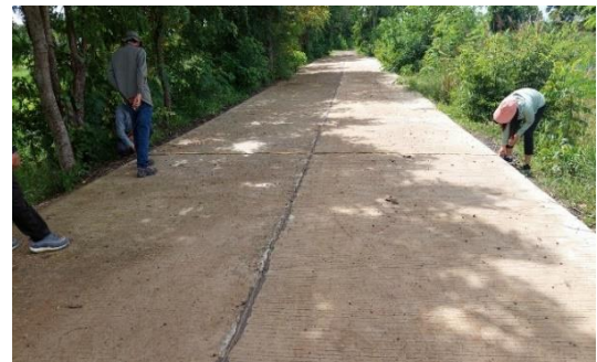
โครงการถนนจากบ้านหนองบัว หมู่ที่ 6 ตำบลห้วยแคน อำเภอห้วยแถลง จังหวัดนครราชสีมา เชื่อมบ้านสระแร่ ตำบลหนองกระเทียม อำเภอลำปลายมาศ จังหวัดบุรีรัมย์ (ก่อสร้างถนนคอนกรีตเสริมเหล็ก กว้าง 5 เมตร ยาว 178 เมตร หนา 0.15 เมตร มีพื้นที่เทคอนกรีตไม่น้อยกว่า 890 ตารางเมตร ตามแบบและรายละเอียดที่ อบจ.นม.กำหนด)
