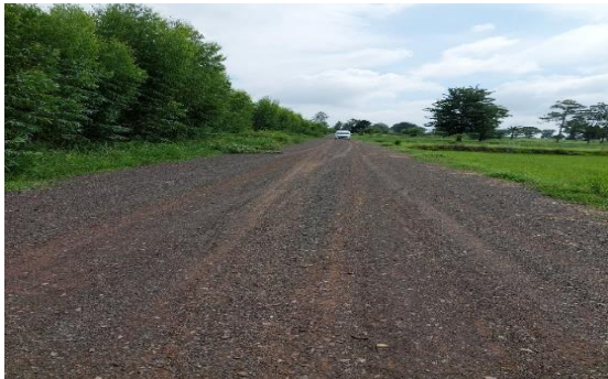
โครงการถนนบ้านจิตประสงค์ หมู่ที่ 1 รหัสสายทาง นม.ถ.259 - 08 สายหนองโจดจิตประสงค์ ตำบลลุงเขว้า เชื่อมตำบลแหลมทอง อำเภอหนองบุญมาก จังหวัดนครราชสีมา (ก่อสร้างถนนหินคลุก กว้าง 5 เมตร ยาว 585 เมตร หนา 0.15 เมตร หรือมีพื้นที่ก่อสร้าง ไม่น้อยกว่า 2,925 ตารางเมตร ตามแบบและรายละเอียดที่ อบจ.นม.กำหนด)
